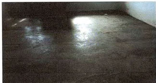
piso del area de cocina remozado
