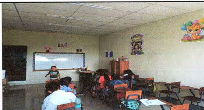
techo de aula numero uno remozado
