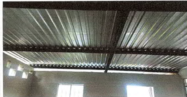
techo del area de cocina remozado
