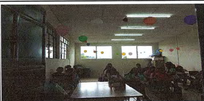
ventanales y techo aula numero dos remozados
